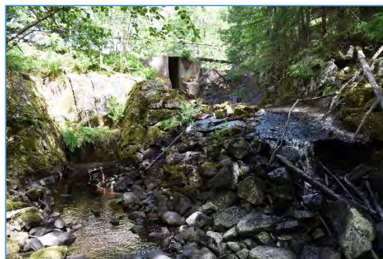
Bild nr 57: Dammen vid Bergsjön sedd från nedströmssidan.
