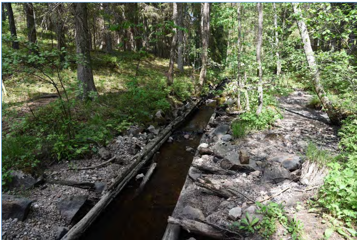
Bild nr 64: Rensad, rätad och kanaliserad del av strömsträckkorna uppströms Sågdammen.
