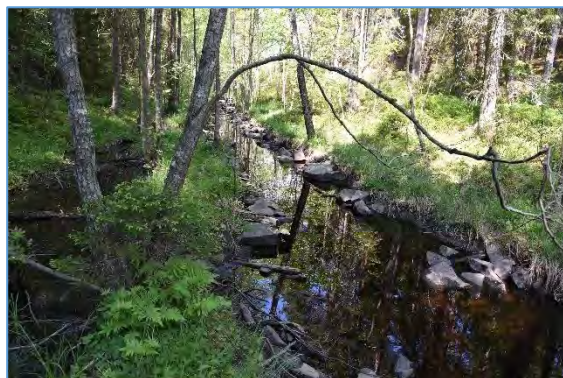
Bild nr 24: Sträcka nr 9. Rester av kantskoningar med stockar finns på sträckan.
